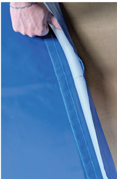
2. Die Folien mit der glatten Seite und dem Klettband an den Seiten nach oben auf den Boden legen. Eine gepolsterten Stange an die Seite legen und mit dem Klettband fixieren.
